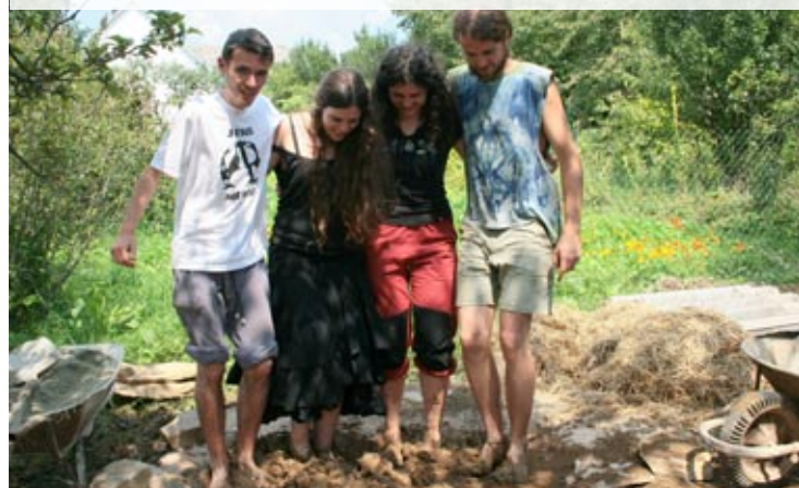
SPOLOČNÉ ŠLIAPANIE HLINY - PRÍPRAVA PRE STAVBU HLINENÉJ BUDOVY
