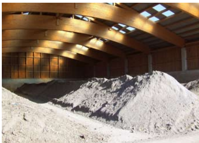
Hala na miešanie a uskladnenie substrátov vyrobených z kompostu
