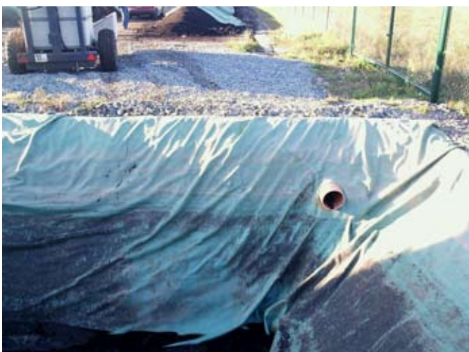
Voda z kompostovacích hromád je zachytávaná v akumulačnej nádrži
